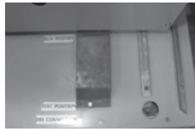
[그림 3] 차단기 외형 및 포지션(Position)
